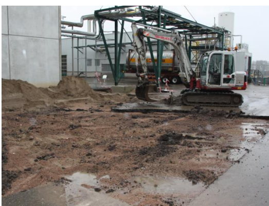
Voorbereidingen voor het heien
