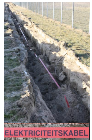
Leggen van de voedingskabel voor de nieuwe trafo
