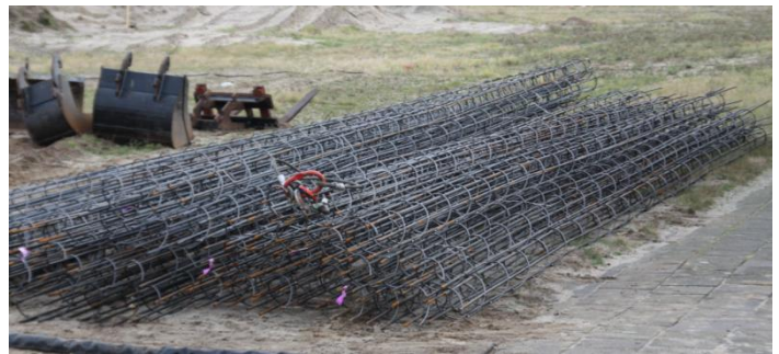
Wapeningskorven voor versterking van de heipaal
