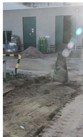
Leggen van de voedingskabel voor de nieuwe trafo
